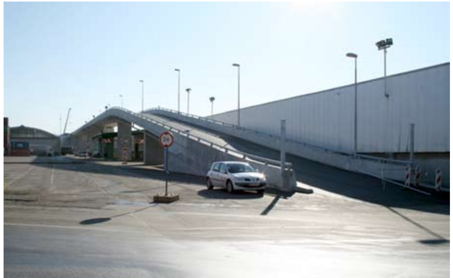
Novozgrajeni viadukt, ki povezuje streho garažne hiše z operativno obalo pomembno prispeva k učinkovitosti terminala.
