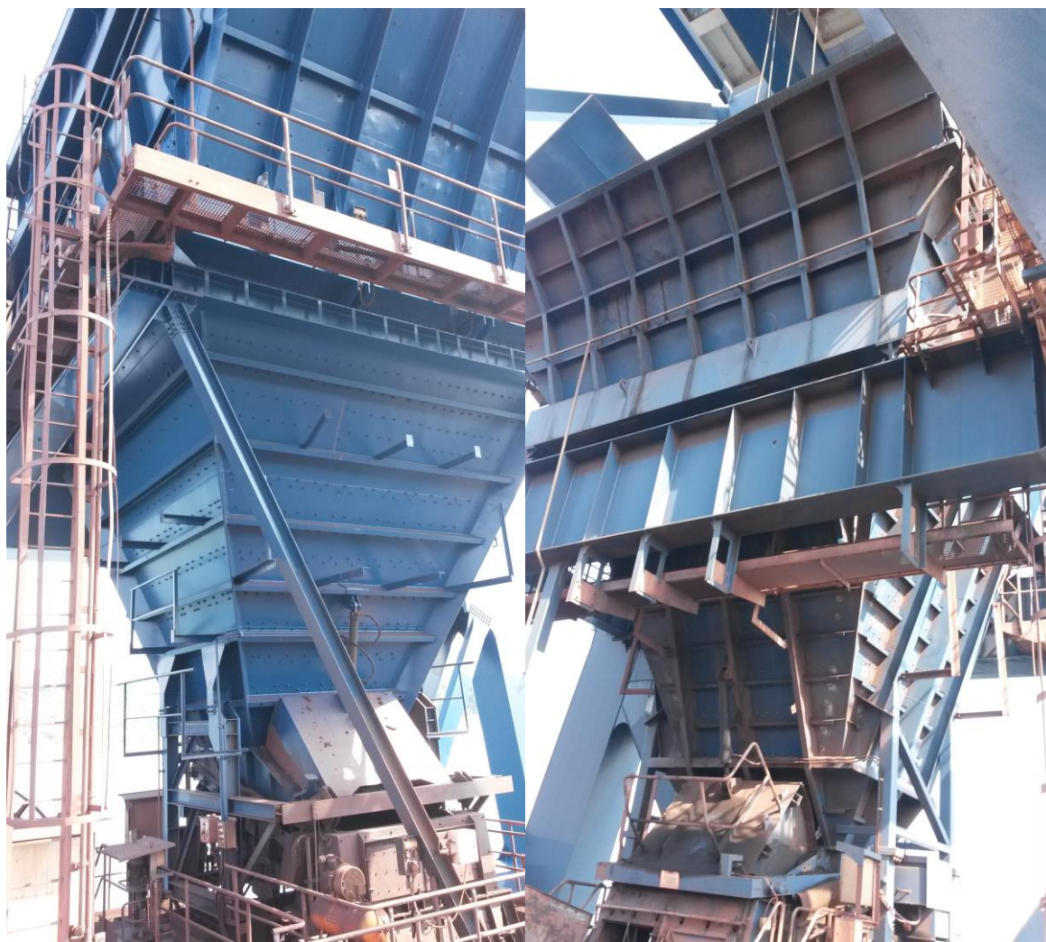
Slika 2: Bunkerja na mostnih dvigalih MD 2 in MD3
