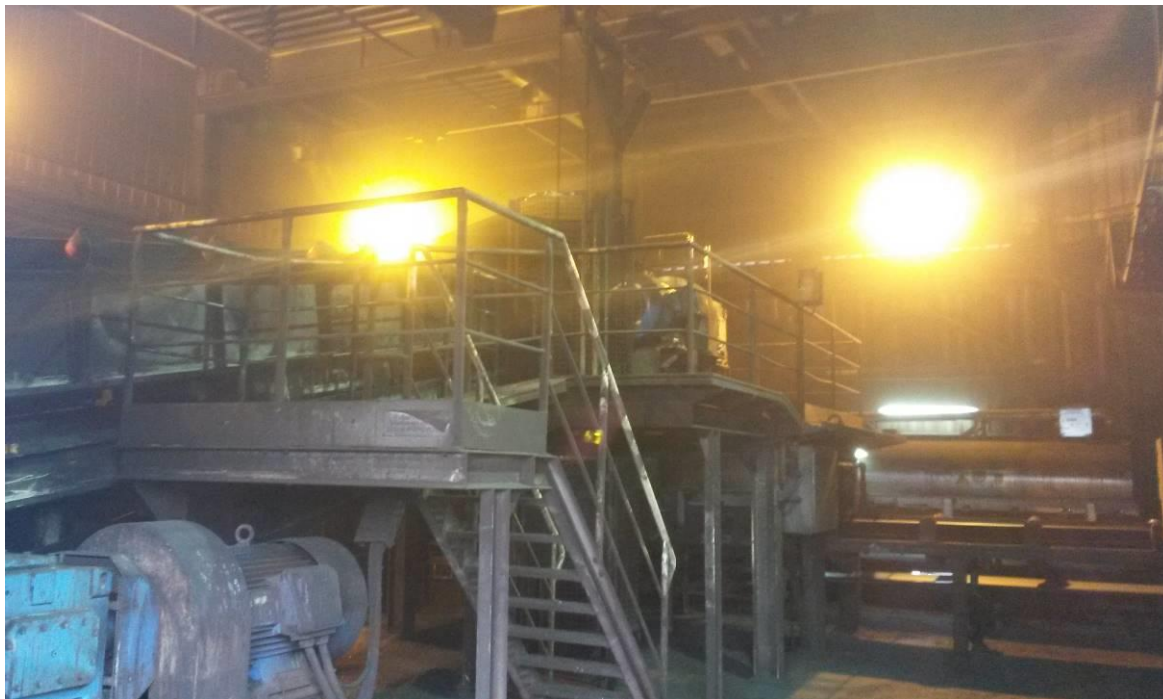
Slika 2: Notranjost kotne postaje
