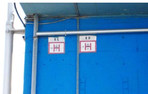
Slika 14 Označevalne tablice vodovoda na fasadi skladišča
