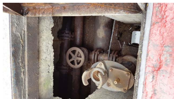
Slika 12 Požarni hidrant v kineti
