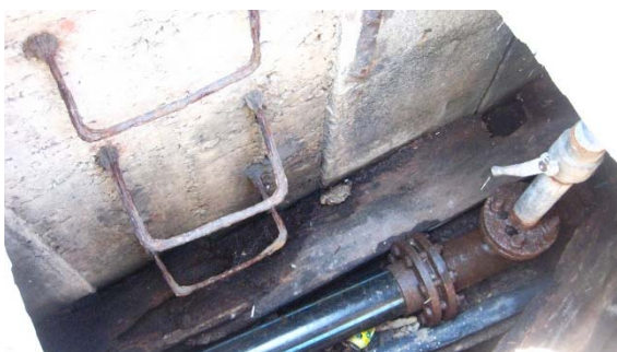
Slika 13 Pogled na dno kinete
