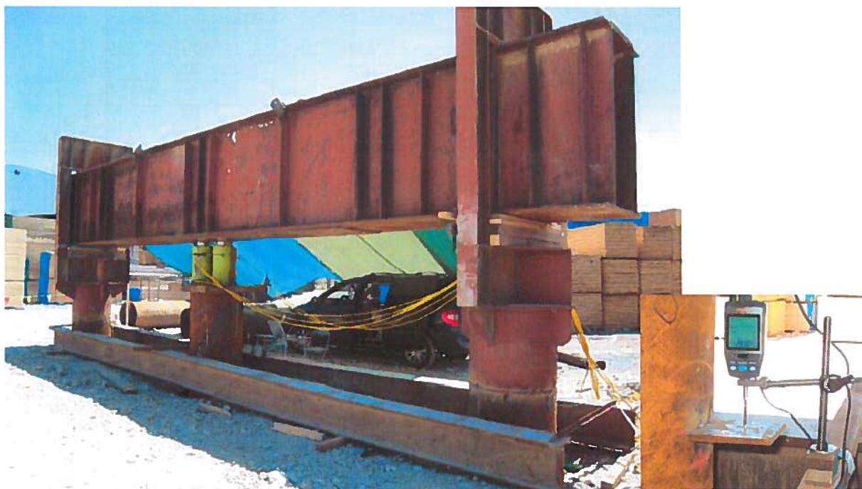
Fotografija 3: Konstrukcija za izvedbo SOT testa
