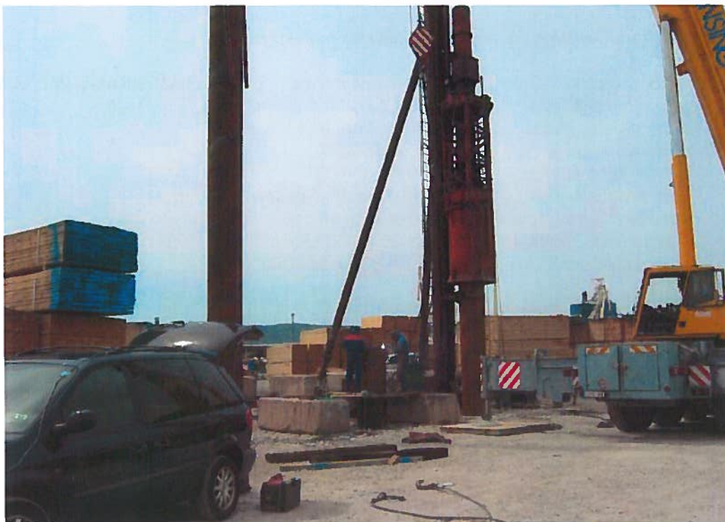
Fotografija 2: Zabijanje testnega kola P1 z dieselskim zabijalom DELMAG D62 in zvonom
