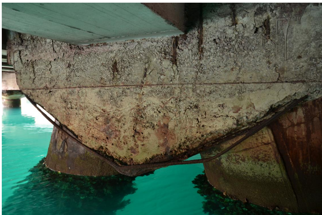
Slika 6: Korozijska poškodba poševnih pilotov.
