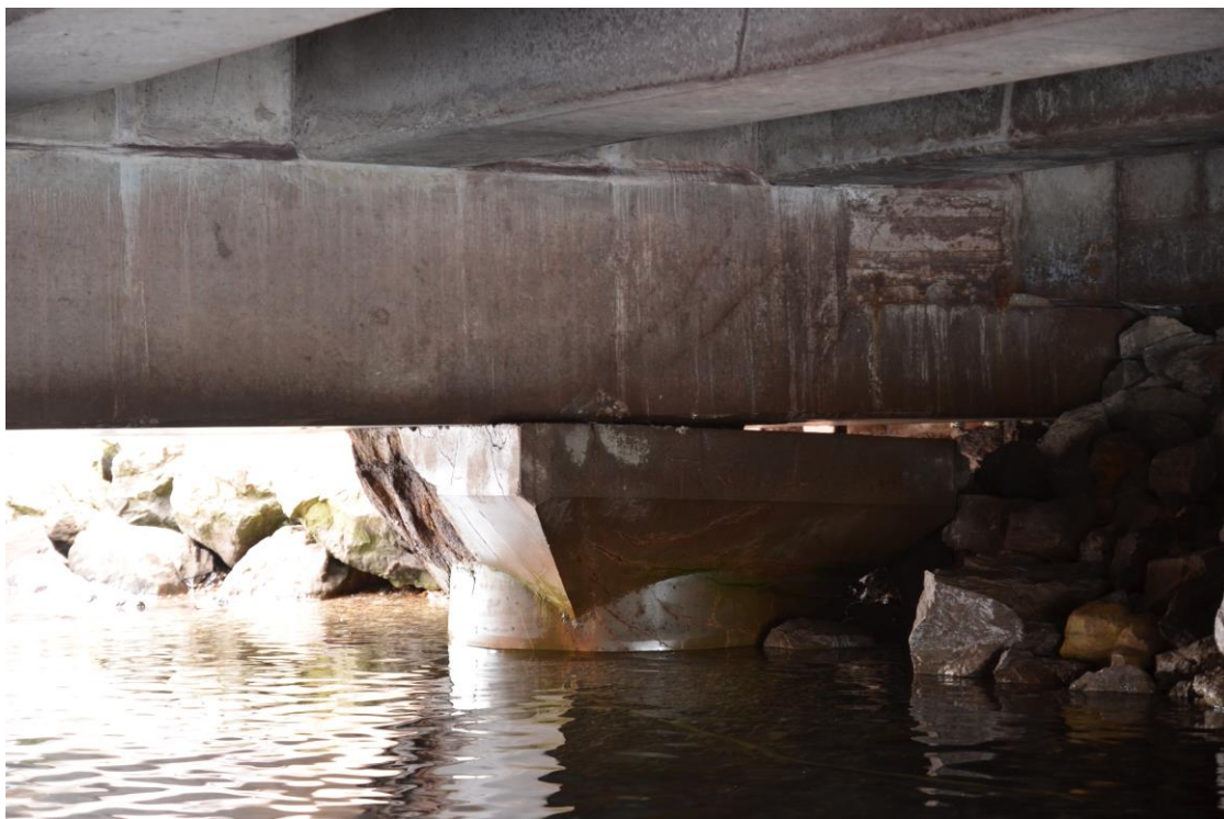
Slika 13: Zasuk med kapo pilotom in vzdolžnikom na dostopnem mostu 3 ob obali.
