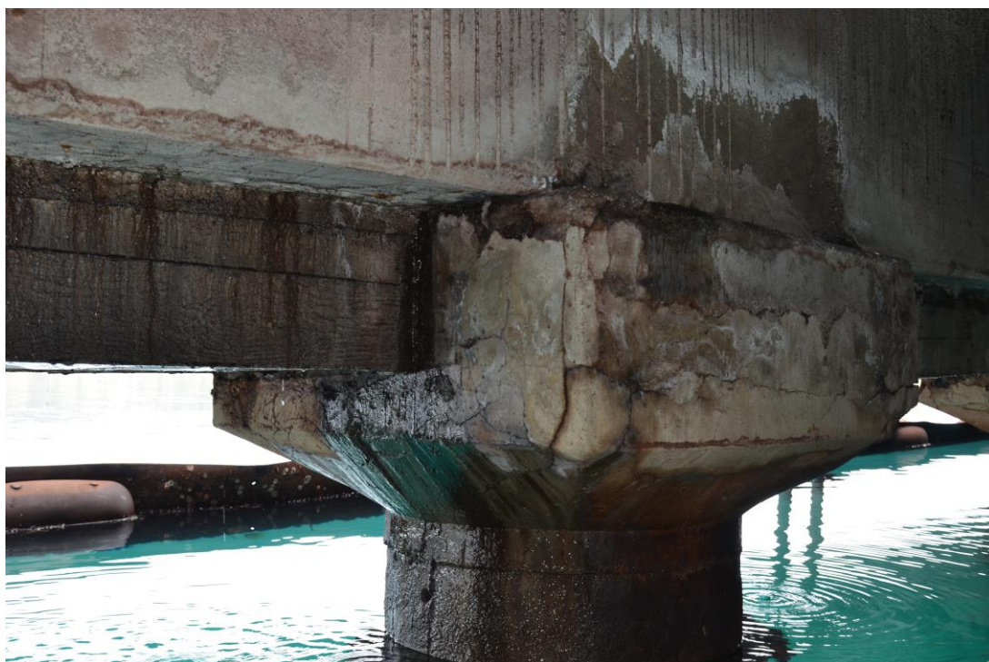
Slika 8: Korozija kap pilotov obale TRT1.
