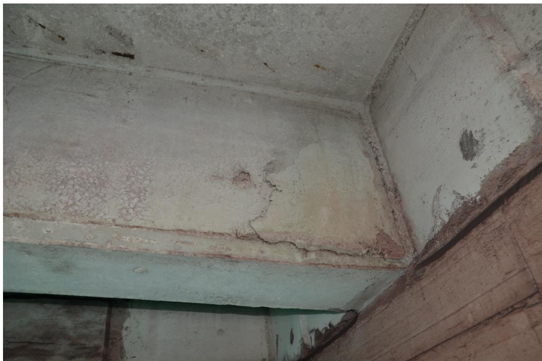
Slika 9: Manjše poškodbe na vzdolžniku delu TRT1.
