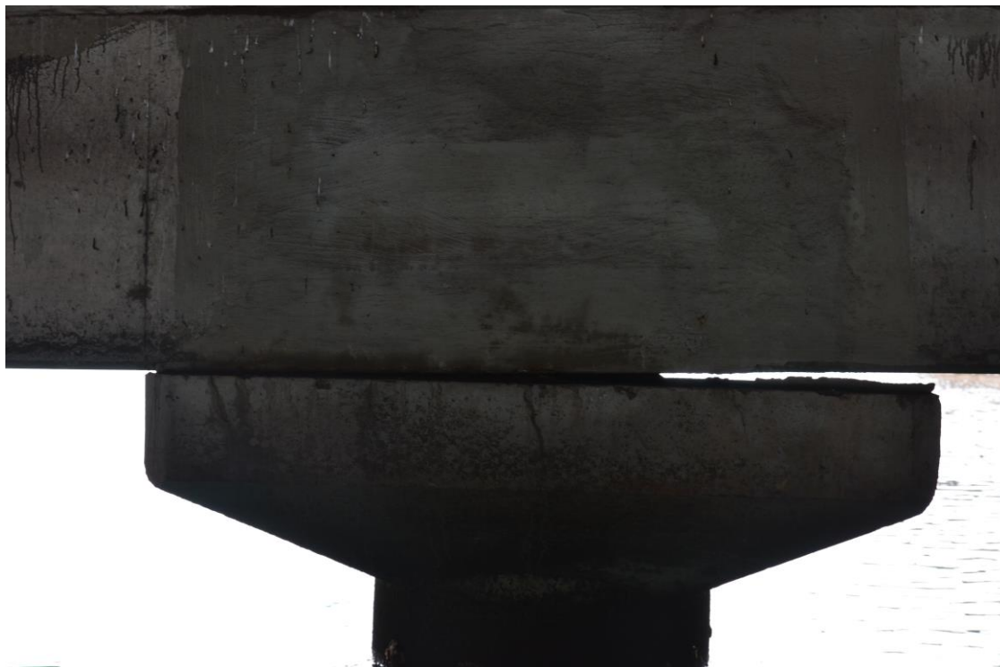
Slika 14: Zasuk med kapo pilotom in vzdolžnikom na dostopnem mostu 3.
