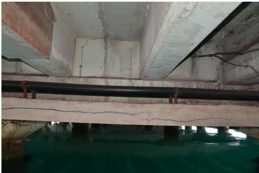
Slika 11: Korozijske poškodbe na prečniku na delu TRT1.
