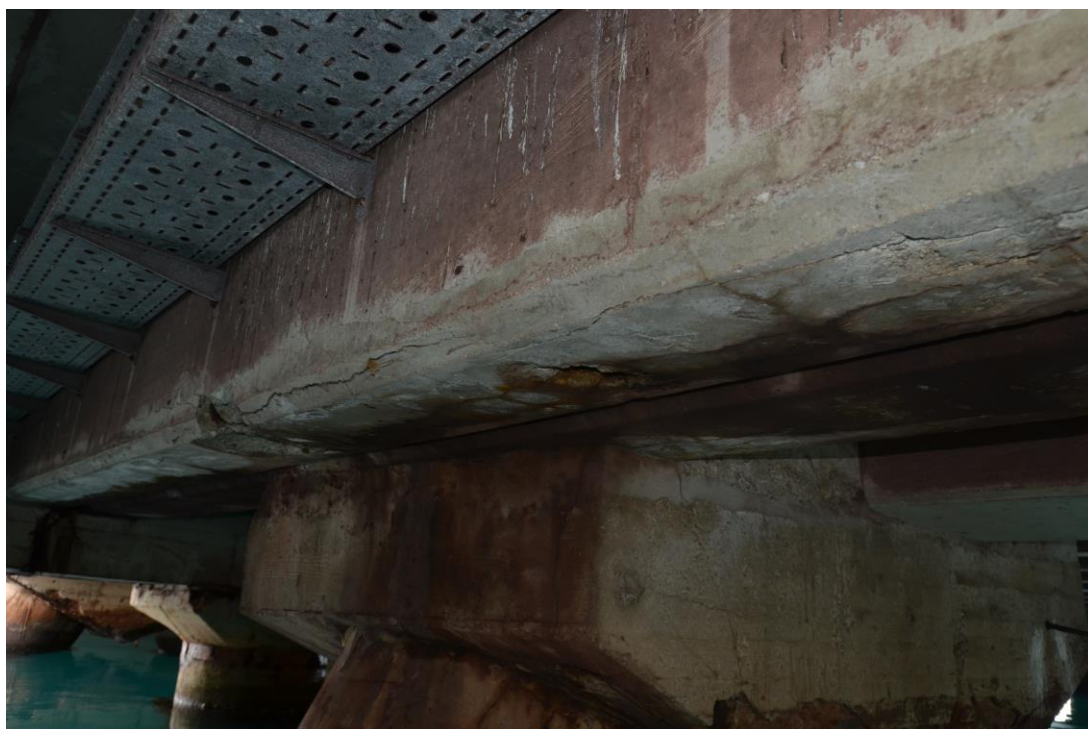
Slika 10: Poškodbe vzdolžnikov na stiku TRT1 in dostopnega mostu 1.
