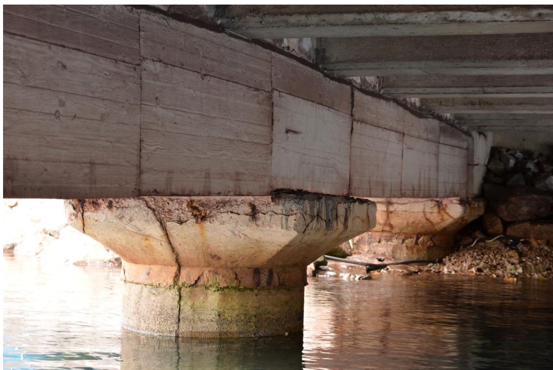
Slika 4: Poškodbe kap pilotov na dostopnem mostu 2 ob obali.
