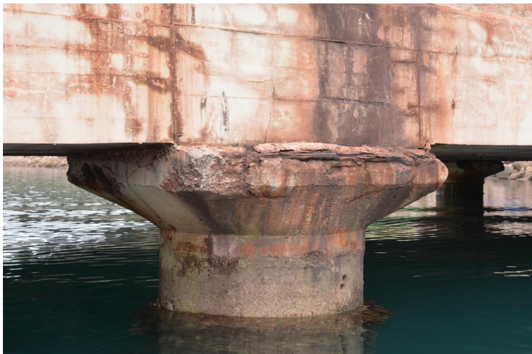
Slika 3: Poškodbe kap pilotov na dostopnem mostu 2.
