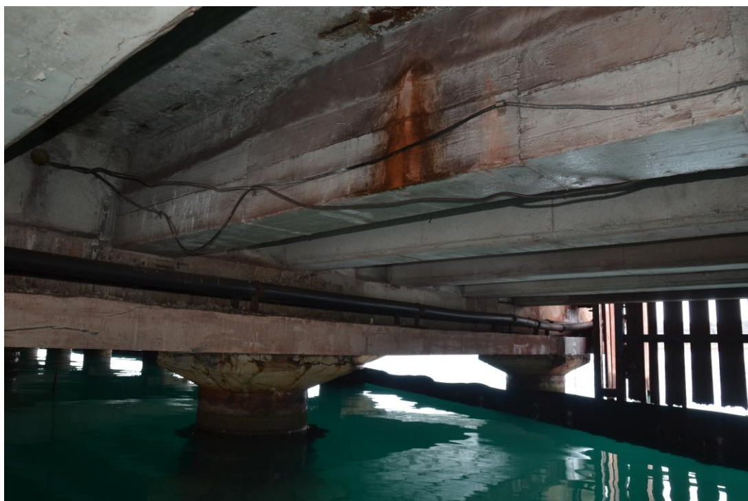
Slika 12: Zamakanje in manjše poškodbe na plošči obale TRT1.
