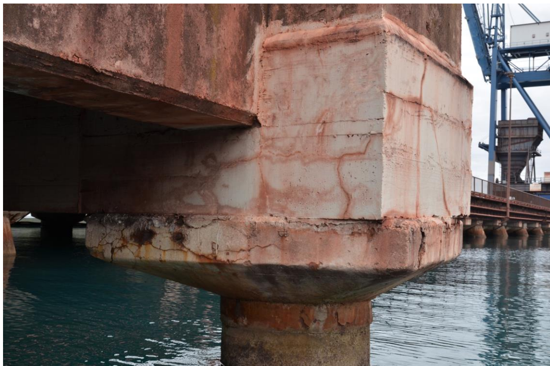
Slika 5: Poškodbe kap pilotov na platoju ob dostopnem mostu 2.
