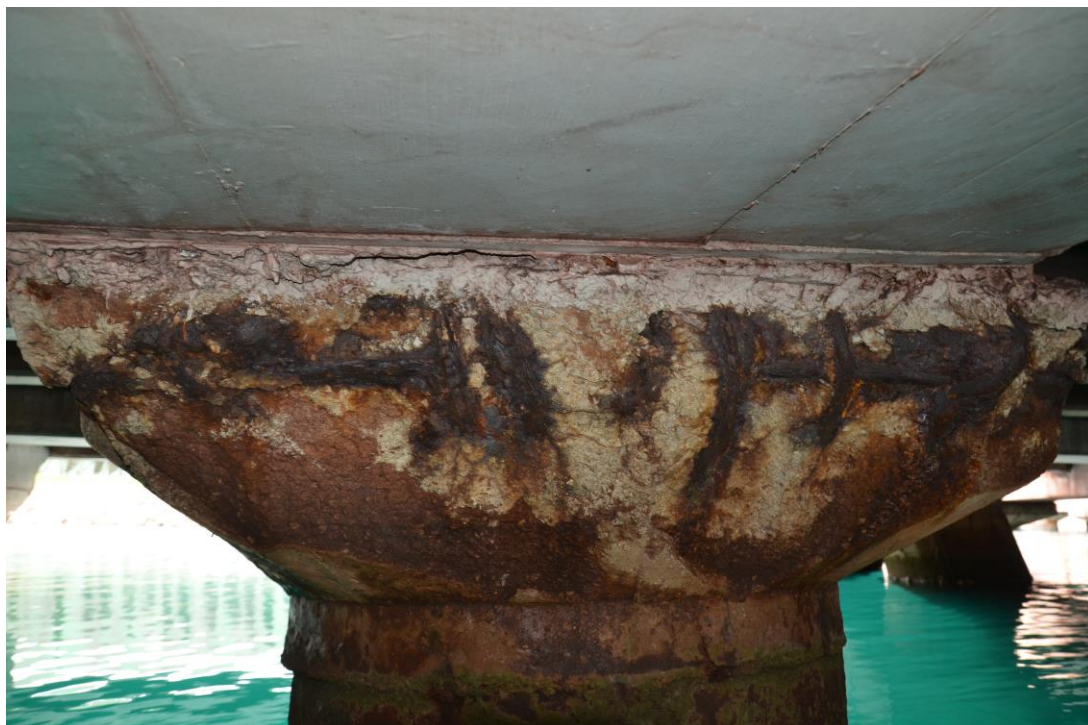
Slika 7: Korozija kap pilotov obale TRT1.
