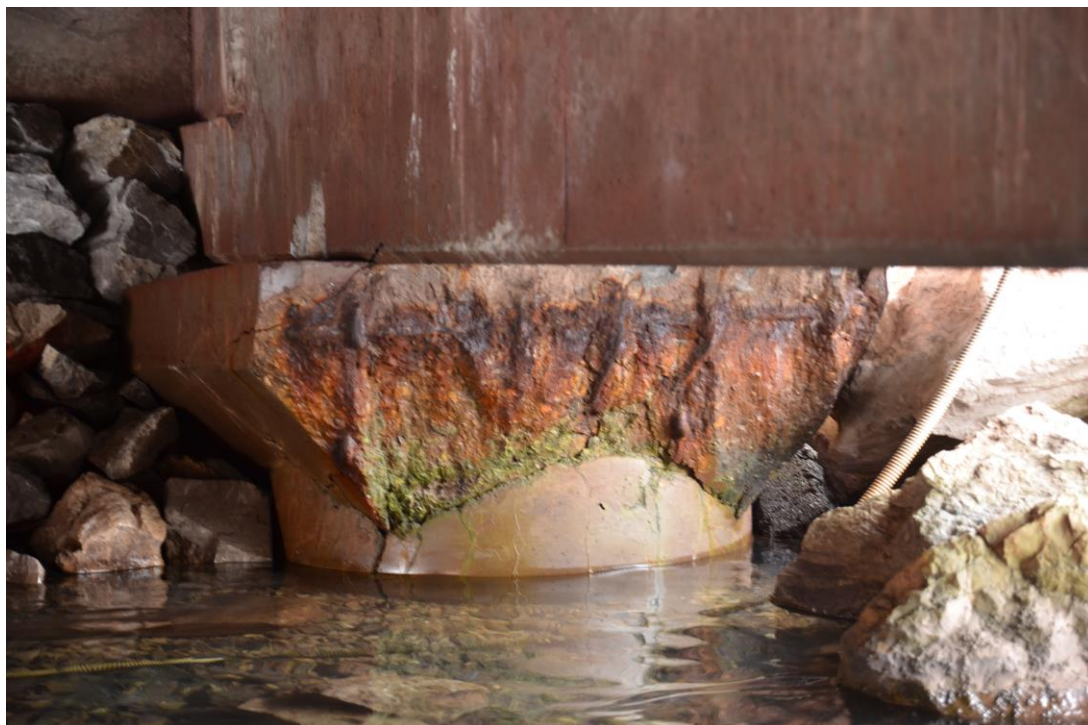
Slika 1: Korozija kap pilotov na dostopnem mostu 3 (ob obali).
