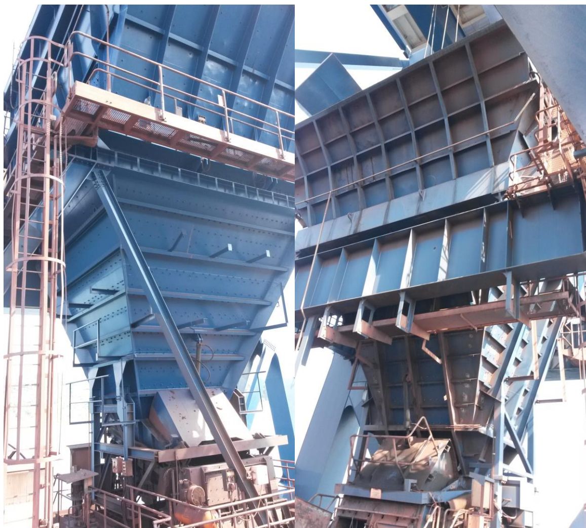
Slika 2: Bunkerja na mostnih dvigalih MD 2 in MD3
