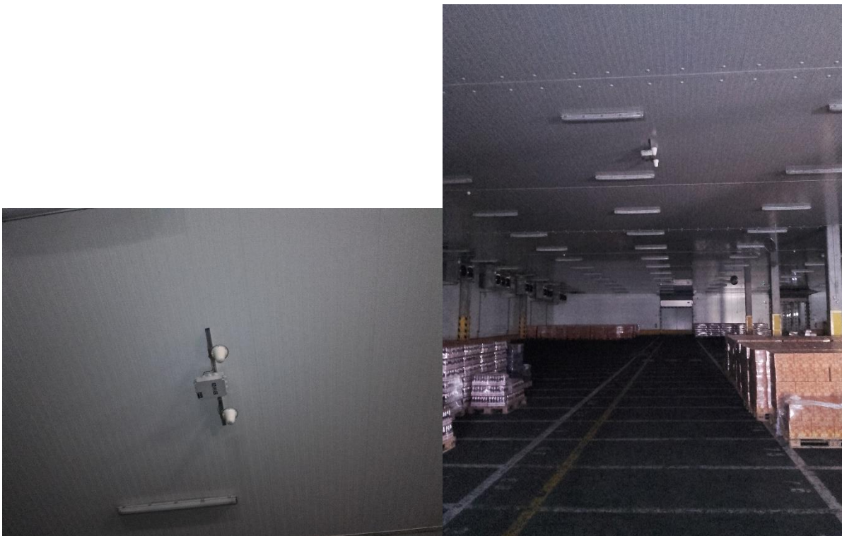
Slika 4: Zamenjava brezžične dostopne točke v skladiščih
