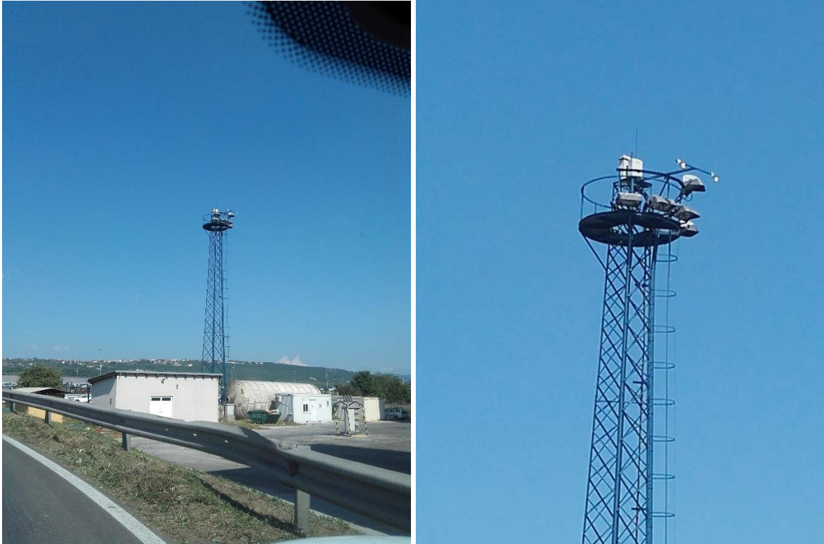
Slika 3: Zamenjava brezžične dostopne točke na svetilnem stolpu višine 20m
