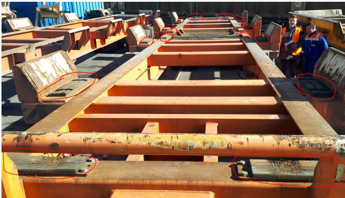
Slika 1: Montaža blažilcev na konstrukcijo prikolic (točka 1)
