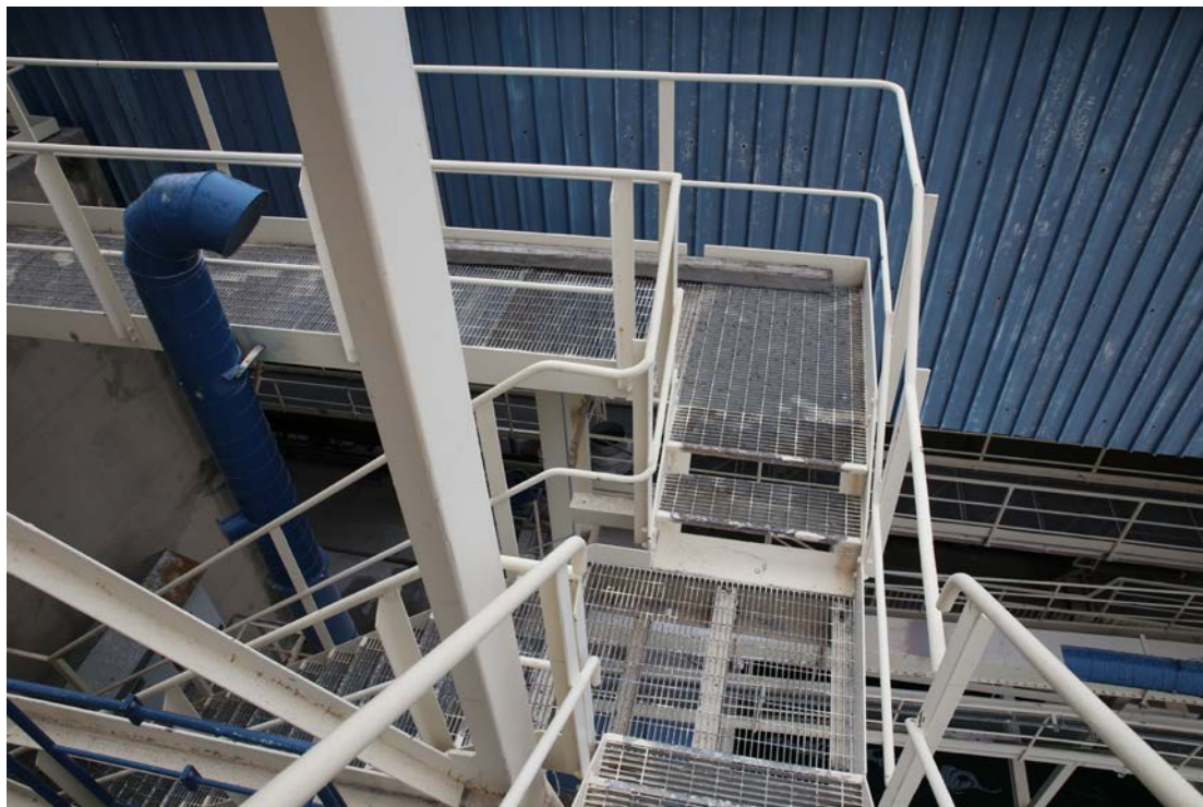
Slika 17 – stopnice in povezovalni hodnik do silosa.
