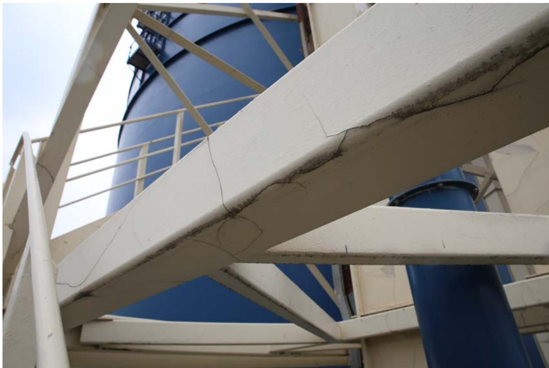
Slika 21 – razpokana barva na horizontalnem povezu.
