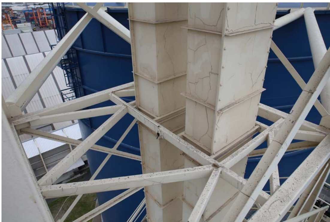
Slika 10 – horizontalno povezje (razpokana barva).
