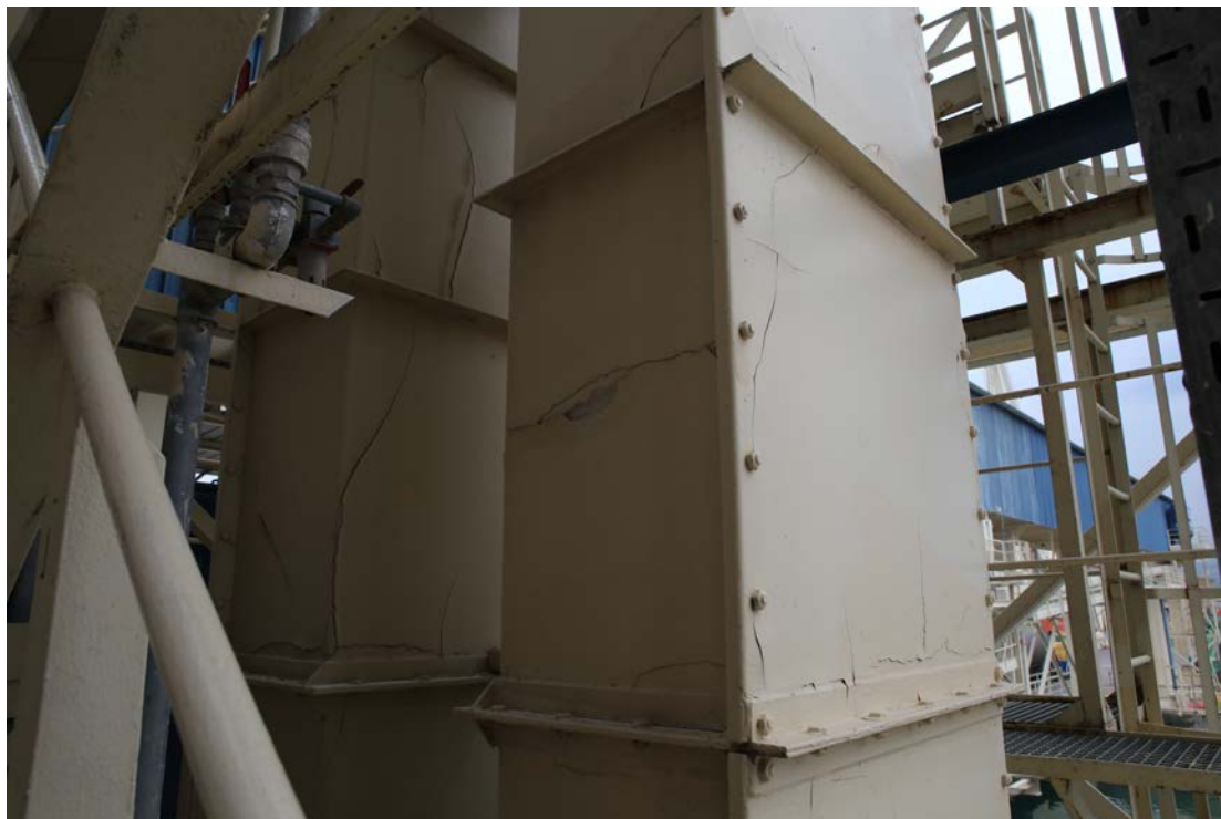
Slika 5 – elevator (razpokana barva).
