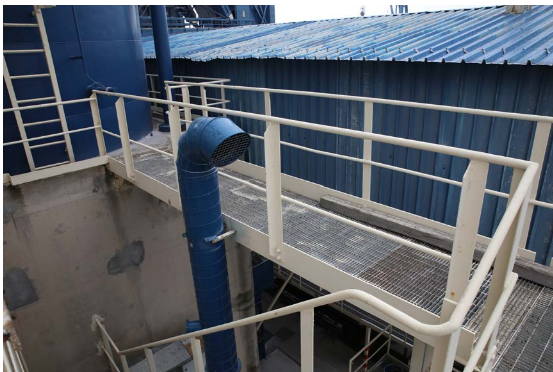
Slika 18 – povezovalni hodnik do silosa.
