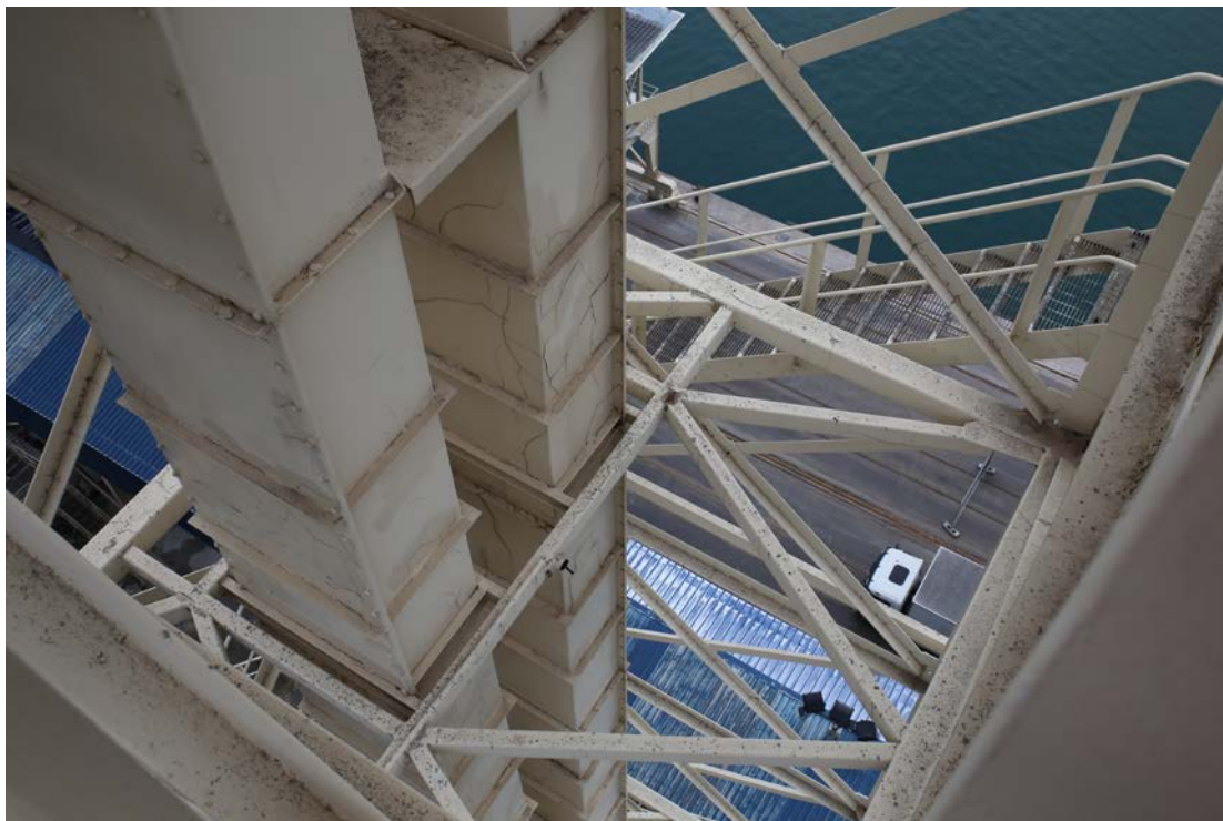
Slika 9 – horizontalno povezje.
