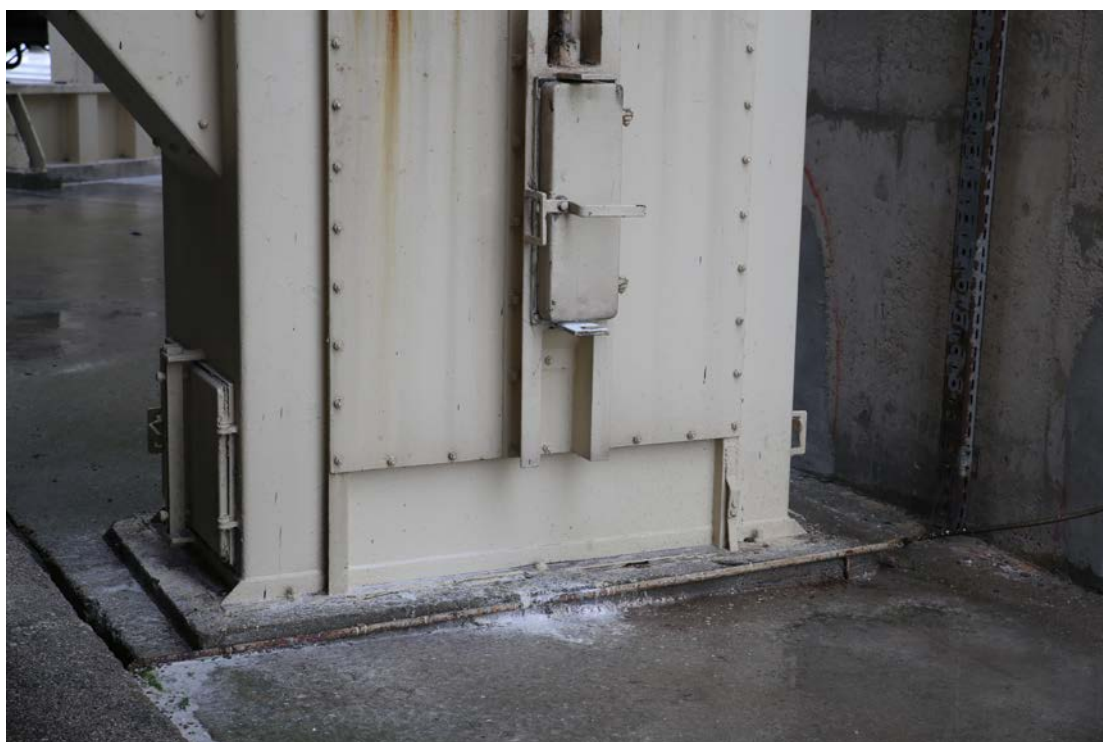
Slika 27 – vznožje manjšega elevatorja.
