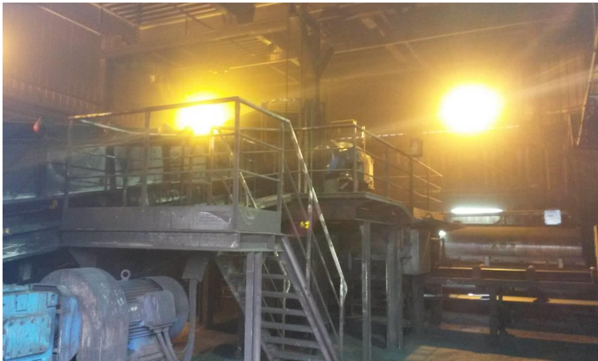
Slika 2: Notranjost kotne postaje
