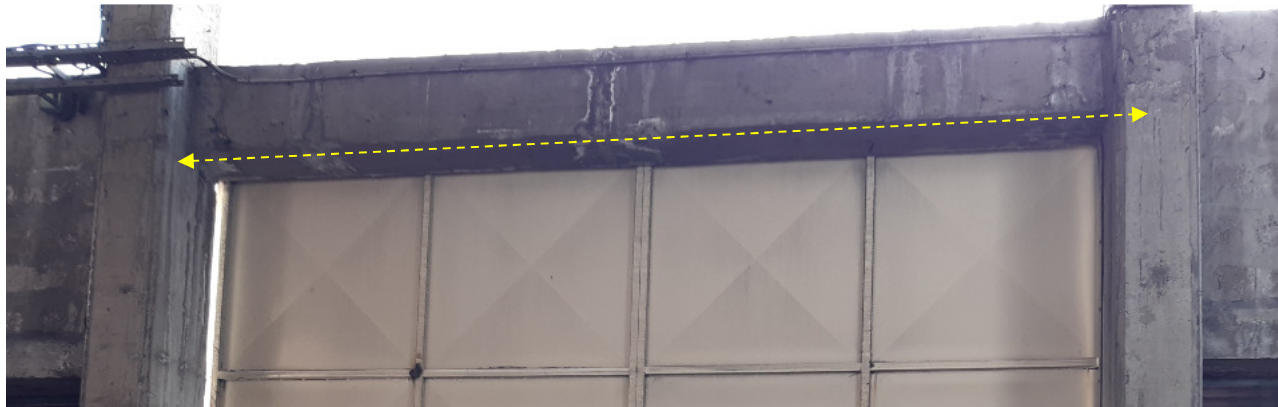
Slika 4: Območje nameščanja zaščitne pločevine med ab vertikalno in horizontalno vezjo
