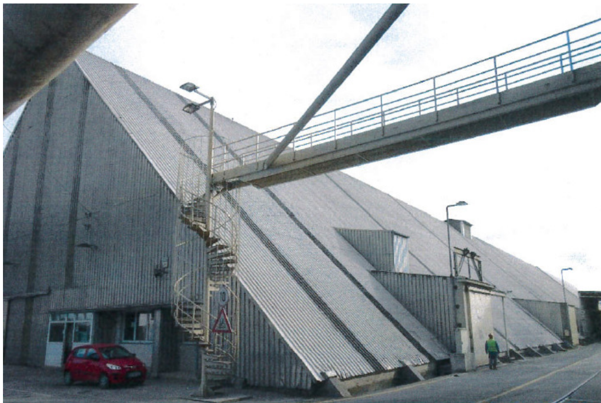
Slika 2: Skladiščna hala TH1
