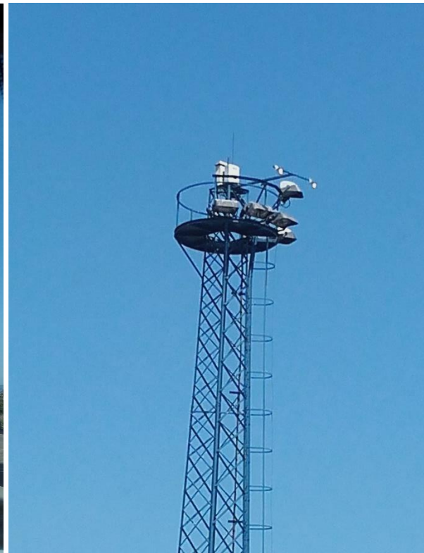
Slika 3: Zamenjava brezžične dostopne točke na svetilnem stolpu višine 20m
