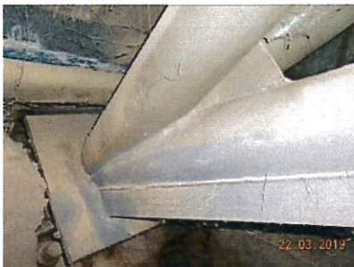
izvedeni (kotni) zvari med elementi paličja – ni bistvenih odstopanj
