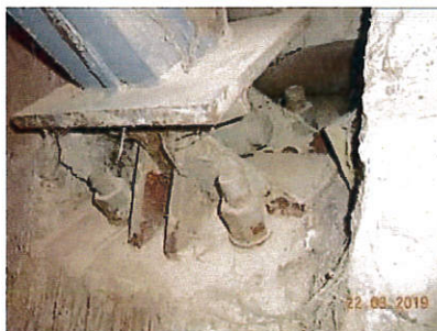
sidrišče nosilca v AB – spodnji del
