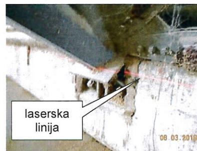
ni vidnih prelomnic zaradi posedkov med AB temeljnim zidom, okoliškim terenom in ploščo znotraj hale
