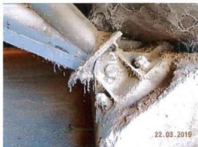
sidrišče nosilca v AB – spodnji del
