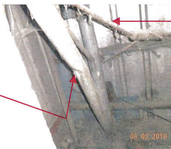
deformacija pasnice nosilca
