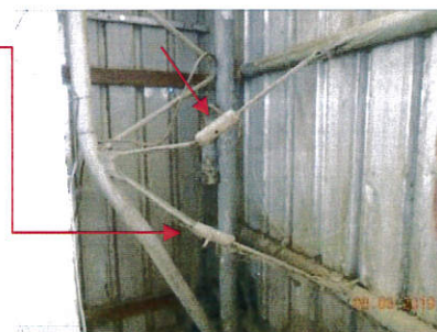
deformacija dveh diagonal
