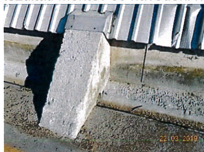
ni vidnih prelomnic zaradi posedkov med AB temeljnim zidom, okoliškim terenom in ploščo znotraj hale
