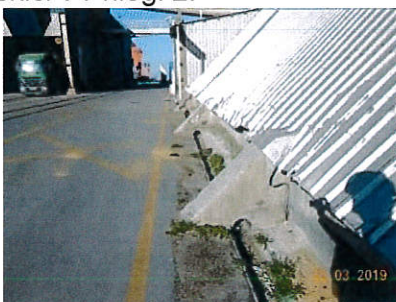
ni vidnih prelomnic zaradi posedkov med AB temeljnim zidom, okoliškim terenom in ploščo znotraj hale
