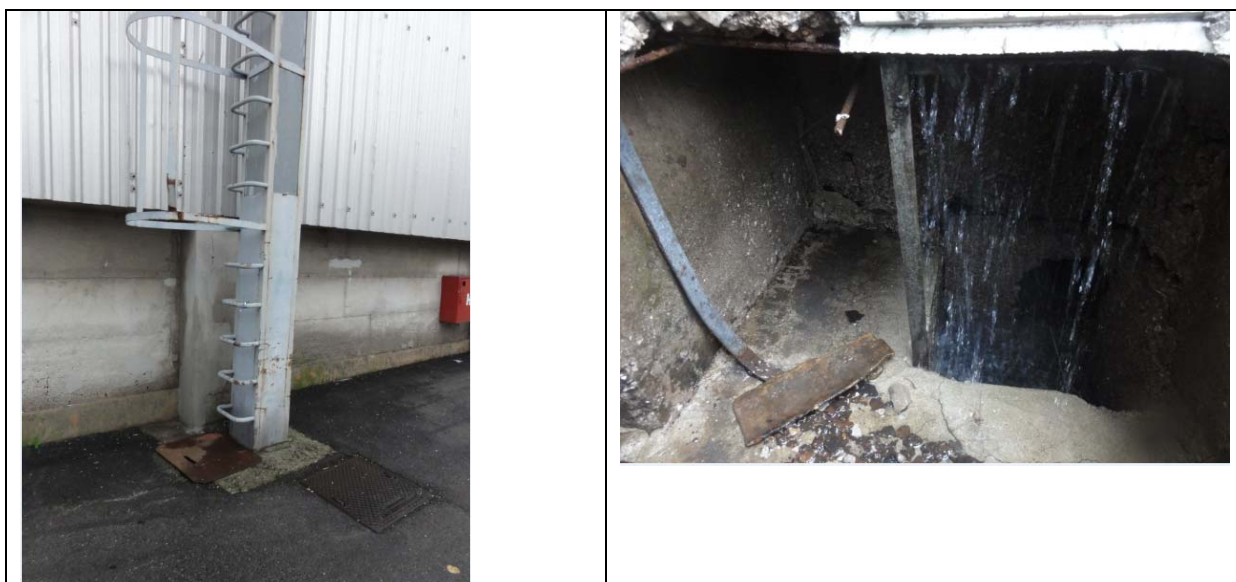
Slika 7: Odtok s pravokotnim prerezom in jeklenim ogrodjem
