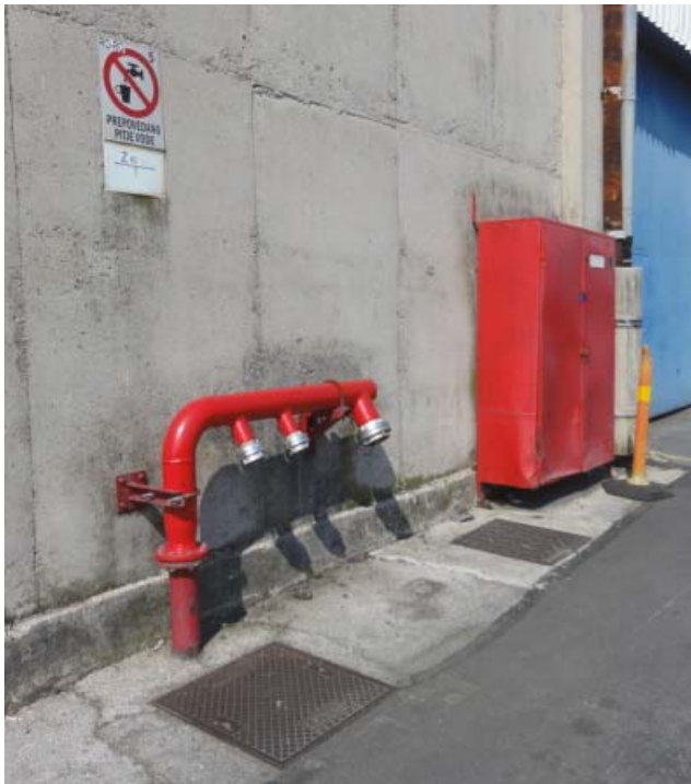
Slika 4: »fajfa« - cev s spojkami 1xA+2xB
