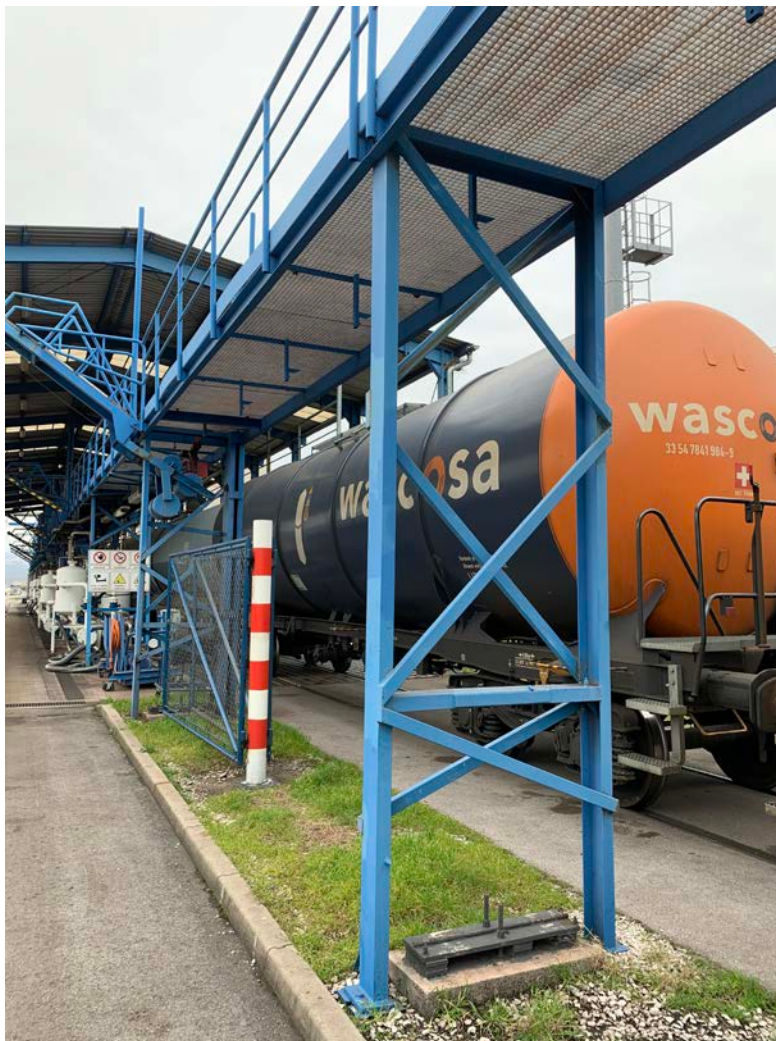
Slika 32 – nepokriti del vagonске polnilnice (pogled proti vzhodu).
