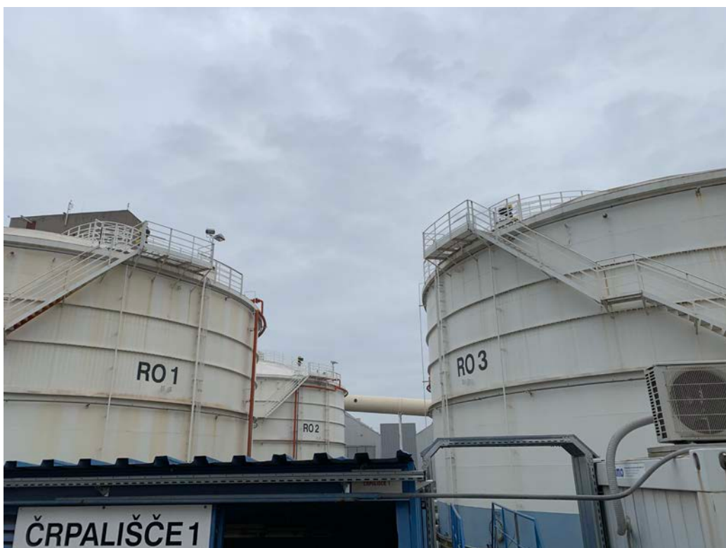
Slika 2 – rezervoarji RO 1, RO2 in RO 3.
