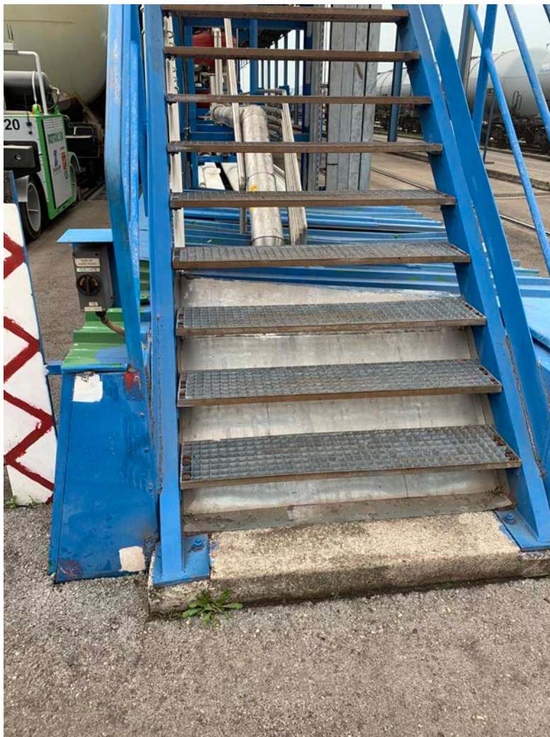
Slika 34 – stopnice za dostop na podest (vzhodna stran).
