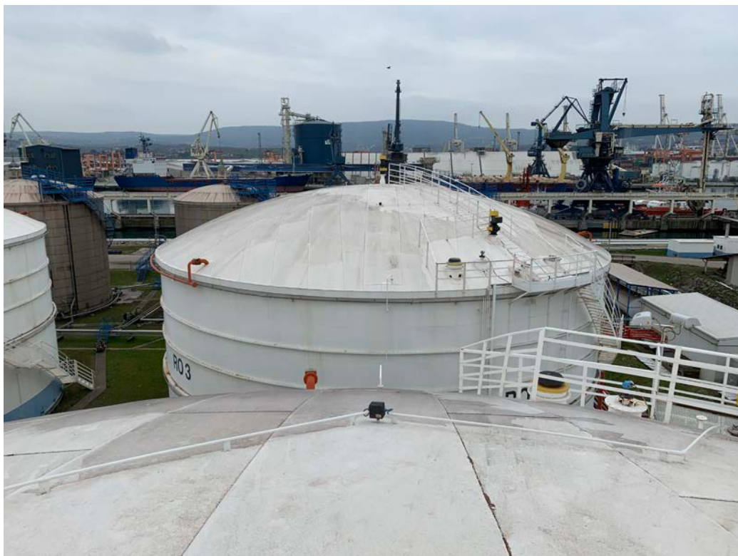
Slika 14 – streha rezervoarja RO 3.
