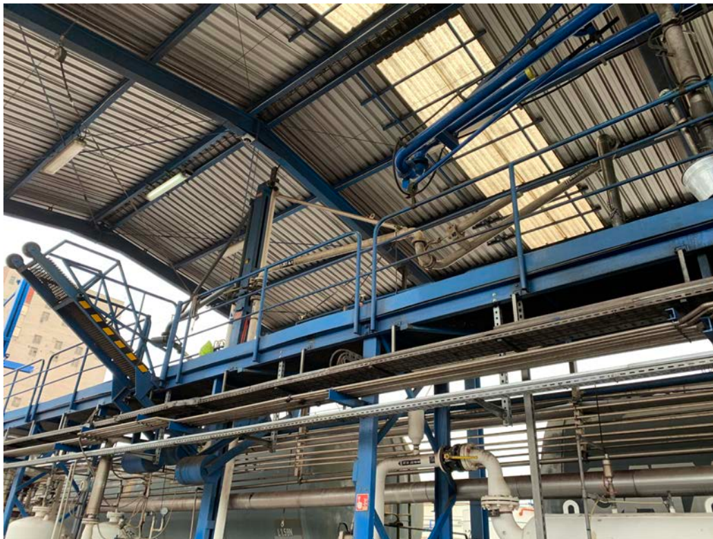
Slika 26 – ostrešje vagonke polnilnice in inštalacijski podest.
