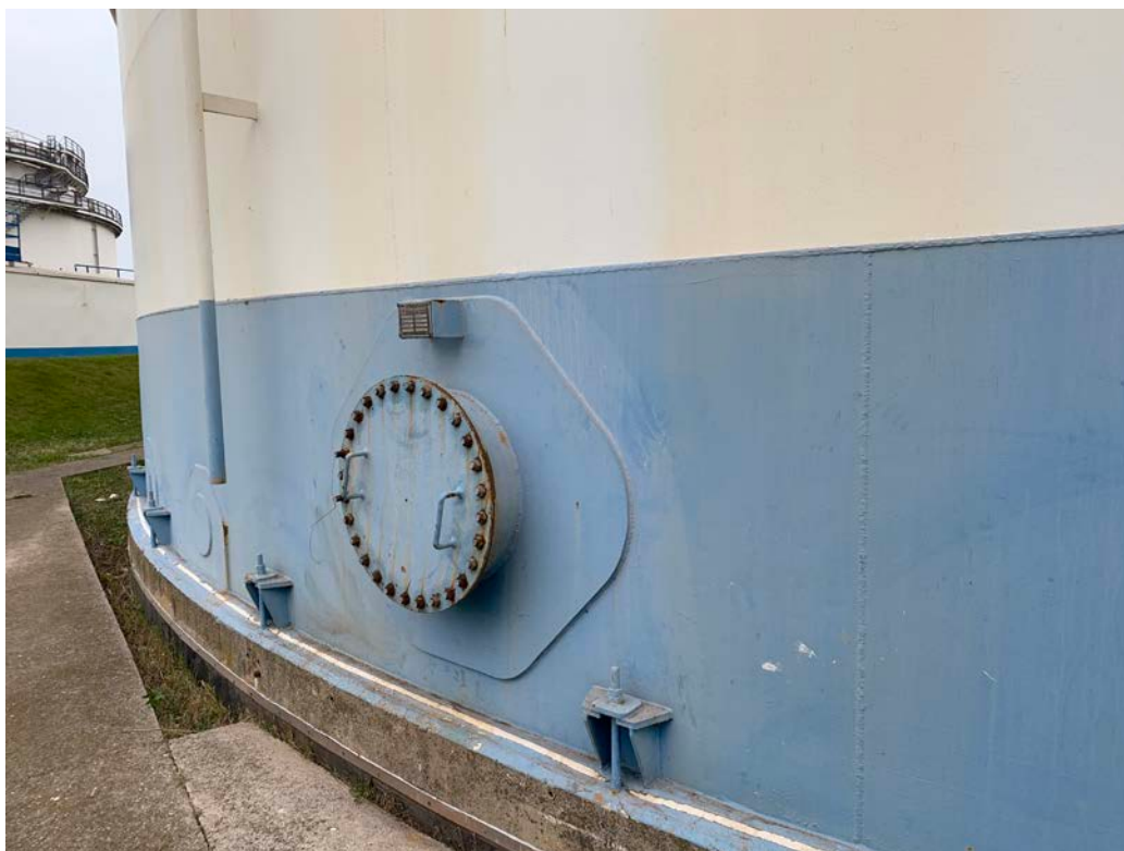
Slika 7 – spodnji del rezervoarja in izpustna odprtina.
