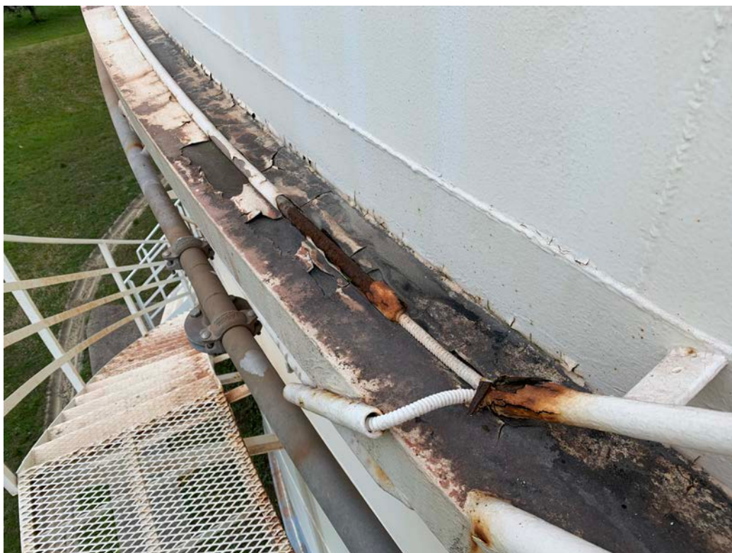
Slika 9 – ojačitev plašča rezervoarja.
