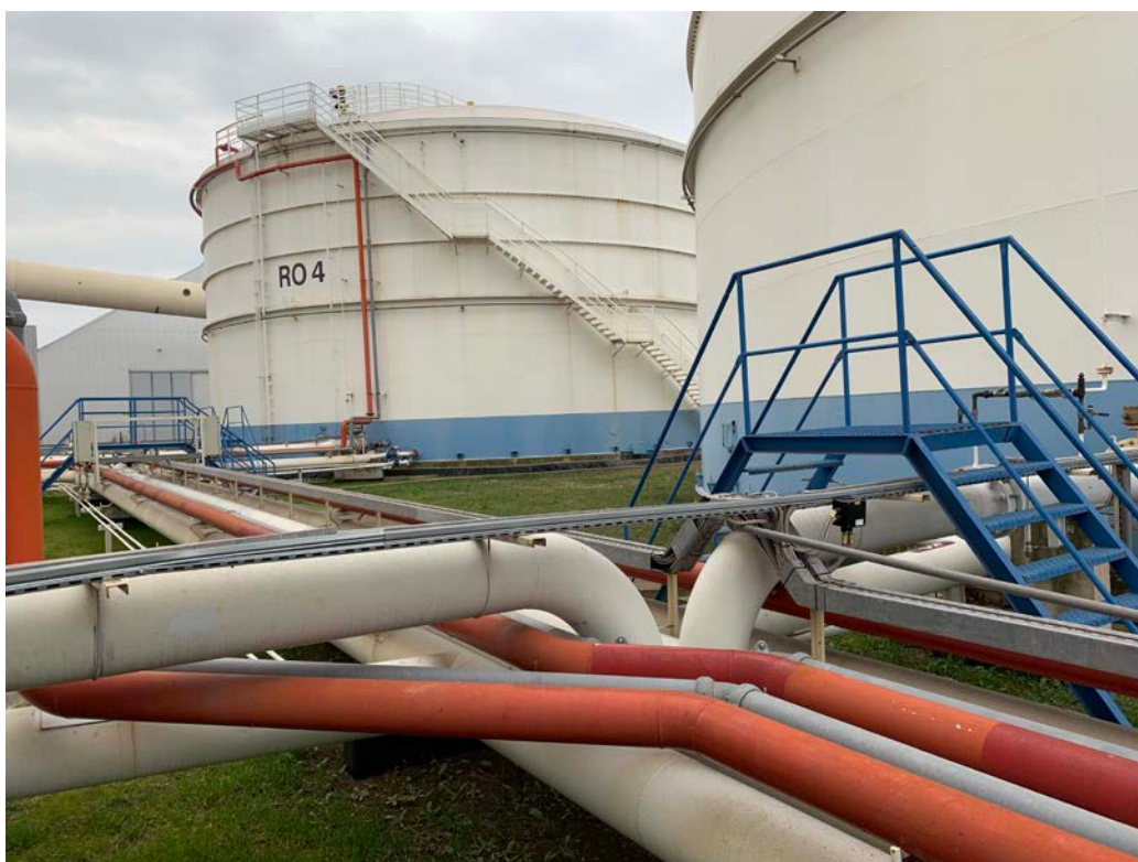
Slika 4 – rezervoar RO 4, cevovod in stopnice.
