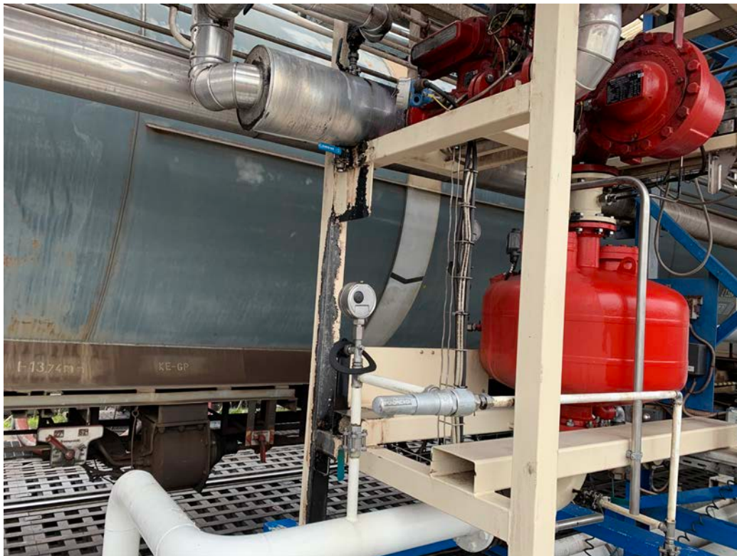
Slika 23 – podkonstrukcija za instalacije in opremo.
