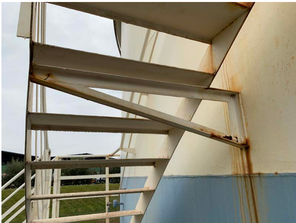
Slika 18 – stopnice ob plašču rezervoarja.
