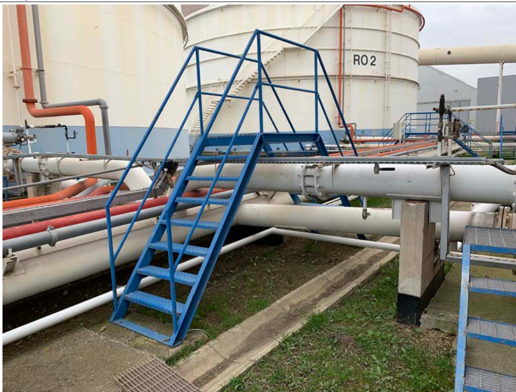
Slika 6 – stopnice čez cevovod.
