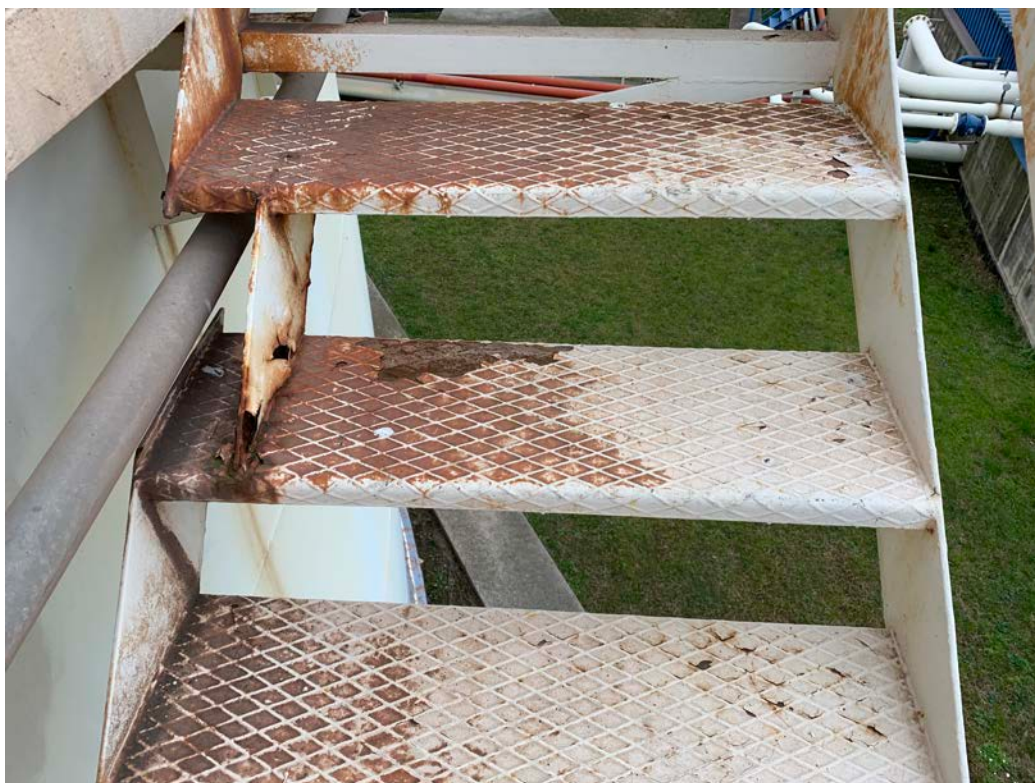
Slika 8 – dostopne stopnice na vrh rezervoarja.
