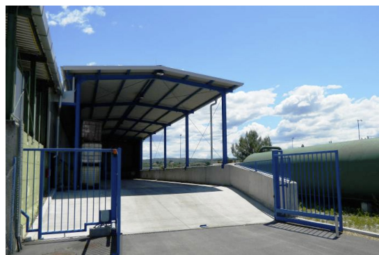
Slika 23: Objekt za predhodno skladiščenje nevarnih odpadkov
