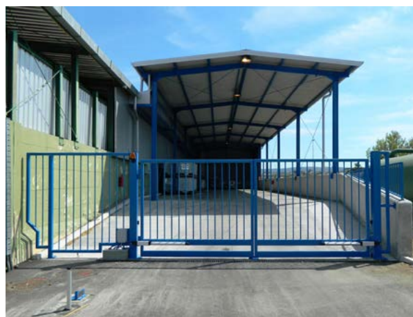
Slika 30: Objekt za predhodno skladiščenje nevarnih odpadkov
