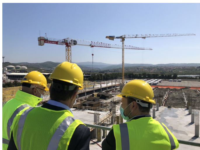
Ogled gradnje garažne hiše
