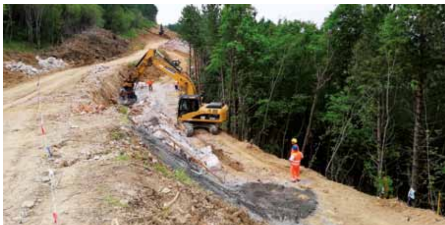
Trenutno poteka gradnja dostopnih cest za drugi tir. Foto: Martin Tomažin
