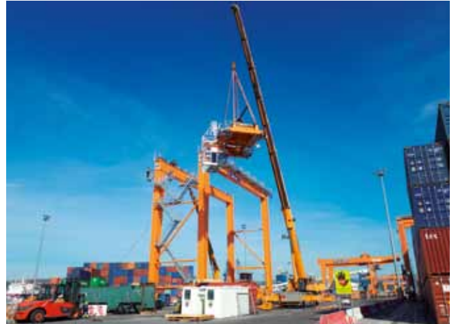
Eden od prvih dveh ERTGjev iz zadnje serije dvigal med sestavljanjem na kontejnerskem dvigalu Luke Koper. Foto: Danjel Zobec
