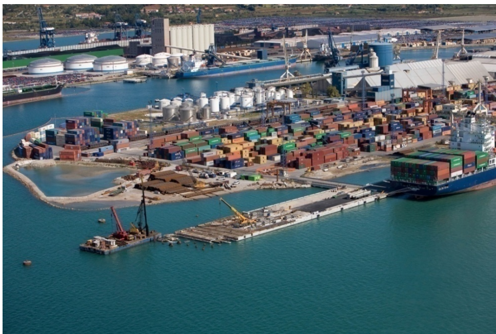
Slika 2: Gradbišče za podaljšanje prvega kontejnerskega pomola
