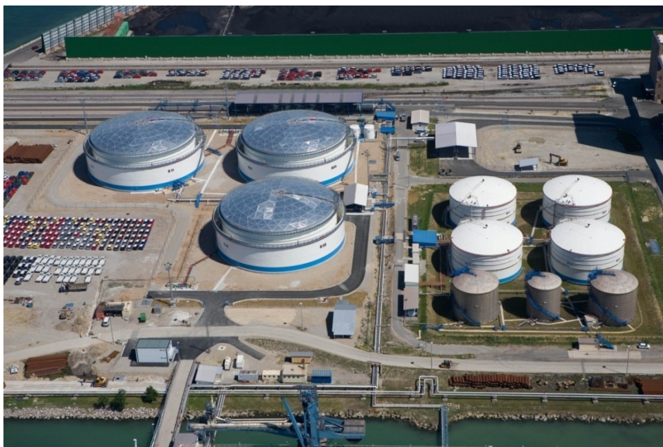
Slika 1: Terminal za sprejem naftnih derivatov
