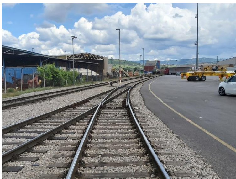
Slika 3: kretnica št. 101, tira 1f in 21c z »K« pritrditvijo in tir 25c z elastično pritrditvijo
