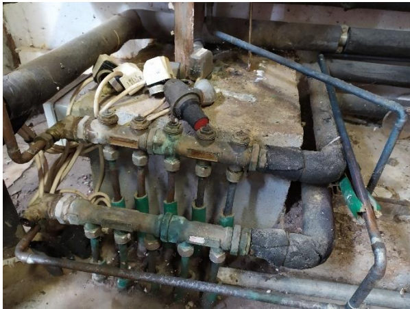
Slika 2 in Slika 3: Poškodovane in dotrajane regulacijske »glave« obstoječih razvodov porabnikov
