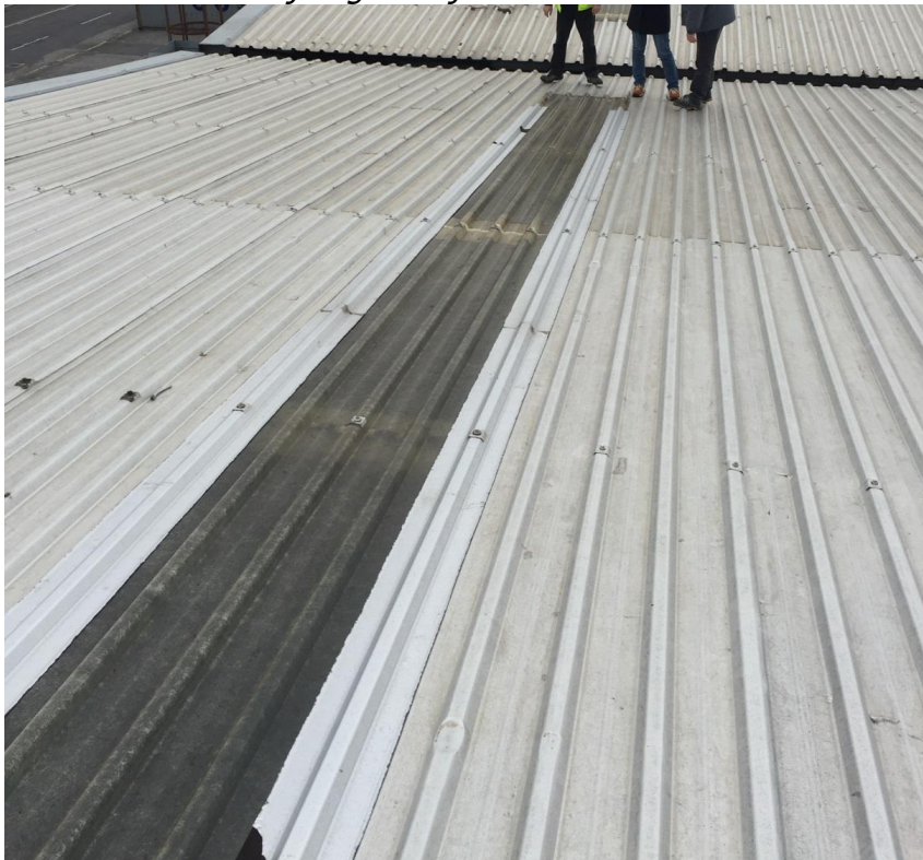
Slika 1. Prikaz obstoječega stanja.
