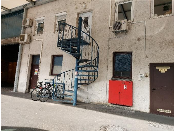
Slika 2-4: Slike obstoječega stanja
