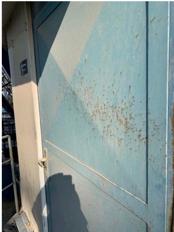
Slika 23 – dotrajana vrata kompresorske postaje.
