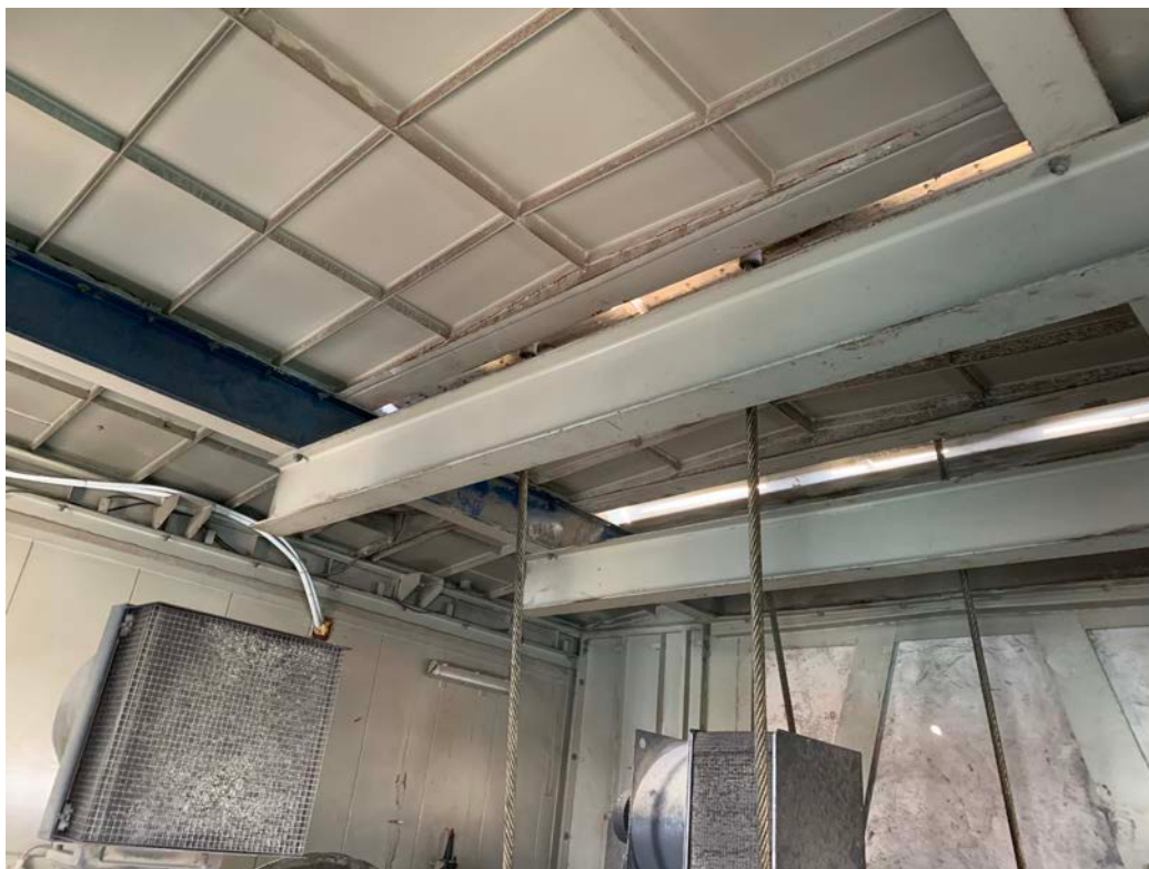
Slika 25 – streha strojnice (znotraj).
