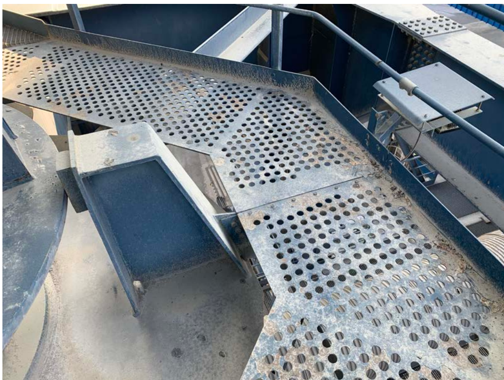
Slika 16 – pohodna pločevina podesta ob ležaju vrtljivega stolpa.
