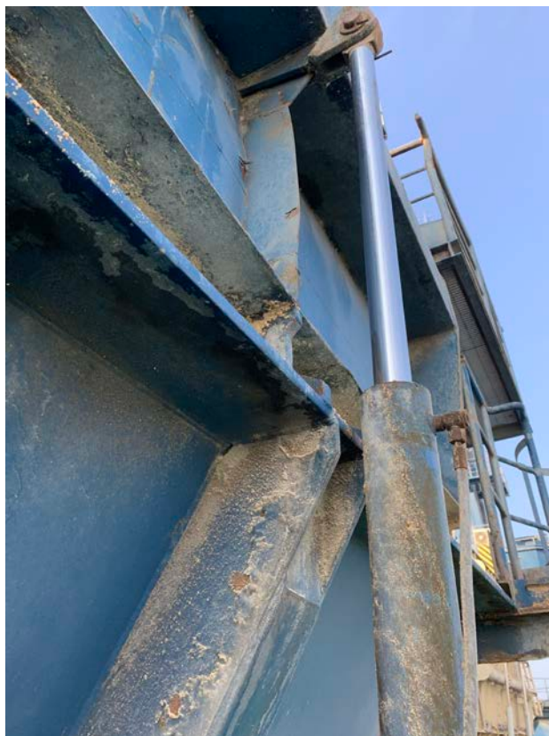
Slika 9 – poškodbe na bunkerju.
