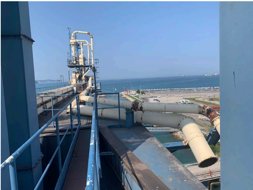
Slika 18 – del cevovoda, ki se odstrani.
