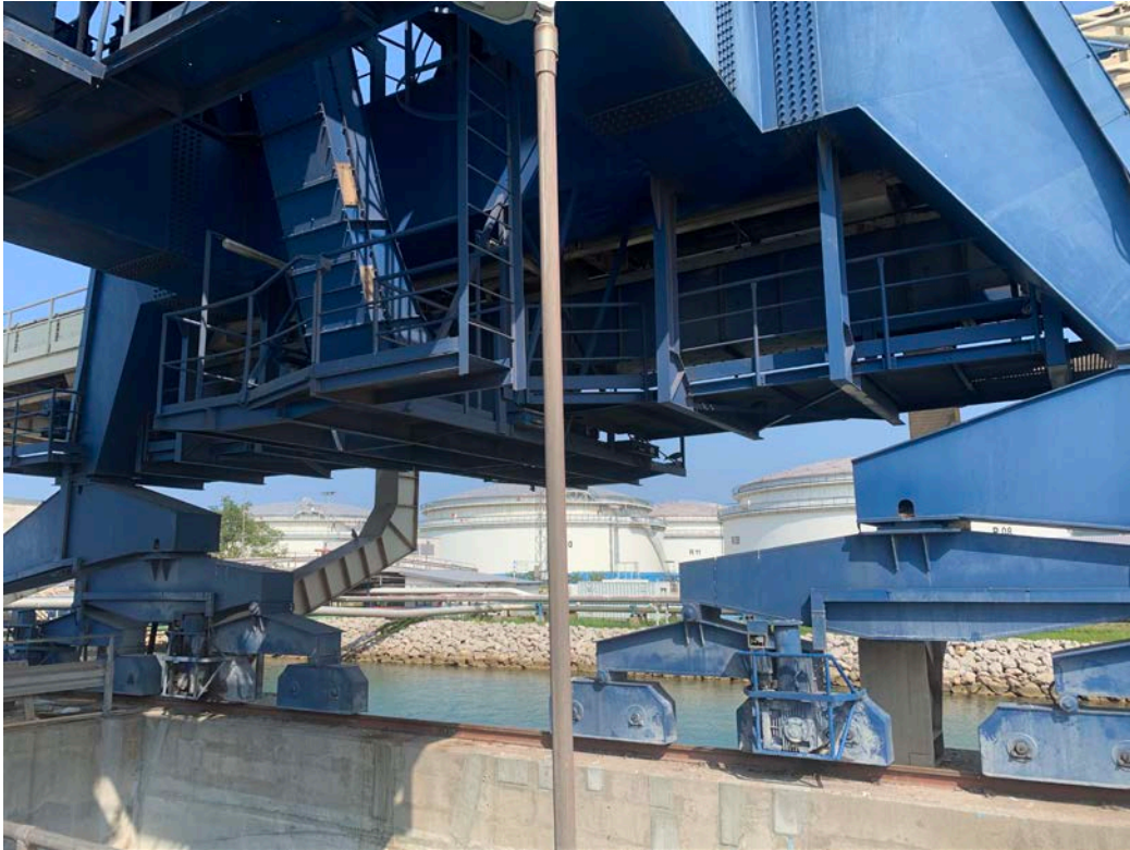
Slika 21 – spodnji del prekladalca (PKZ se osveži s pranjem in enojnim pokrivnim premazom)
