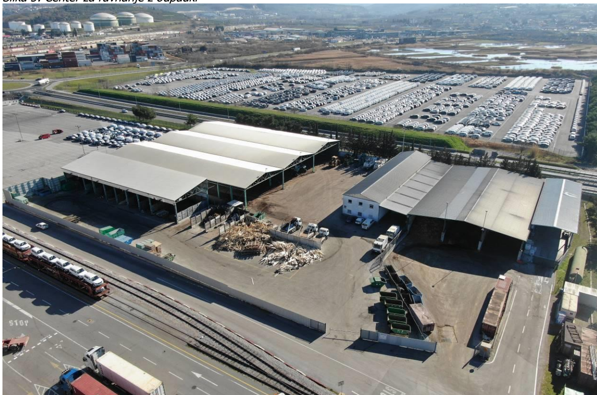
Slika 5: Center za ravnanje z odpadki
