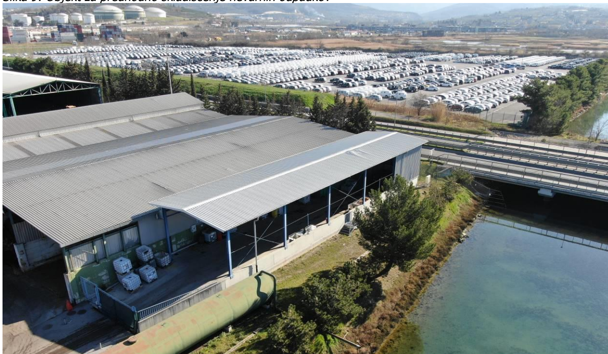
Slika 9: Objekt za predhodno skladiščenje nevarnih odpadkov
