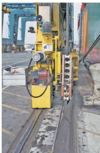
Slika 11: Sistem Panzer belt, proizvajalec Cavotec; Vir: spletna stran https://www.oskom.cz/oskom/File/produkty/Cavotec/panzerbelt_aj.pdf
