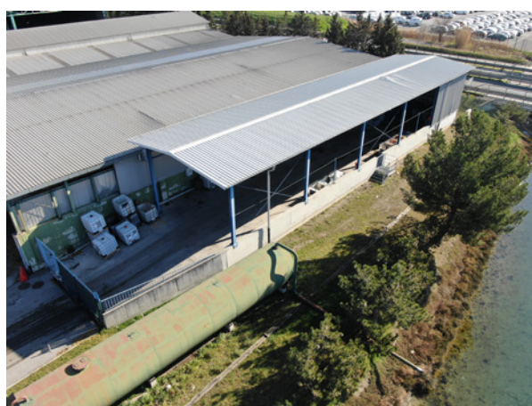
Center za ravnanje z odpadki – območje za skladiščenje nevarnih odpadkov
