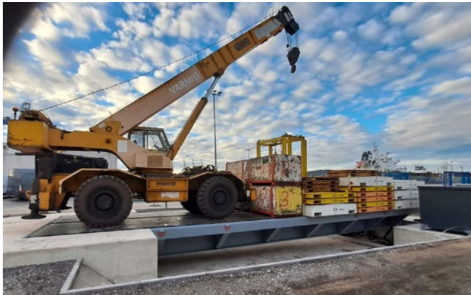
»Obremenitveni test rampe, ko smo za dve uri nanjo naložili 145 ton. Test je nova pridobitev seveda prestala, zato bomo najprej izvedli izobraževanje za zaposlene, ki bodo z njo upravljali, nato pa rampo predali v uporabo,« nam je povedal tehnični vodja Borut Marsič .
