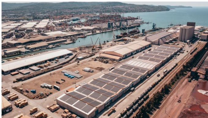
Nova sončna elektrarna Luke Koper se razprostira na 15.000 kvadratnih metrih streh skladišč. Na leto bo proizvedla toliko električne energije, kot je v povprečju porabi 880 gospodinjstev v Sloveniji.
