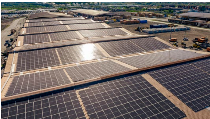
Poleg sončne elektrarne v okviru projekta SOPOREM smo v pristanišču zgradili še dve manjši sončni elektrarni moči 0,9 megavata.
