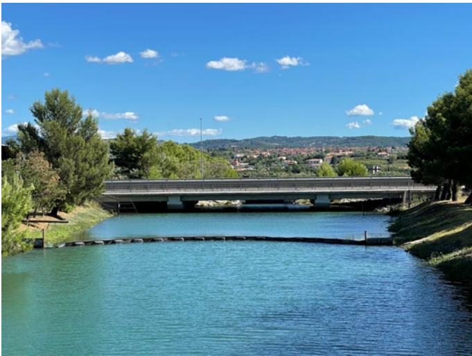
Preliv med morjem in Škocjanskim zatokom fizično varuje baraža, za njo pa še zapornica, s katero lahko omejimo pretok vode, če bi prišlo do onesnaženja.
