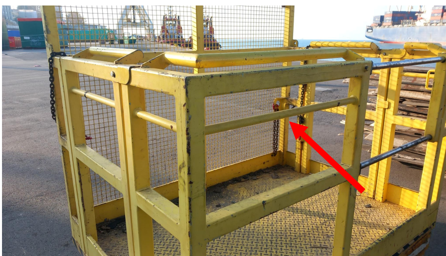
Slika 6: dodatna cev namenjena za priklop varovalne opreme (obstoječa var. košara)
