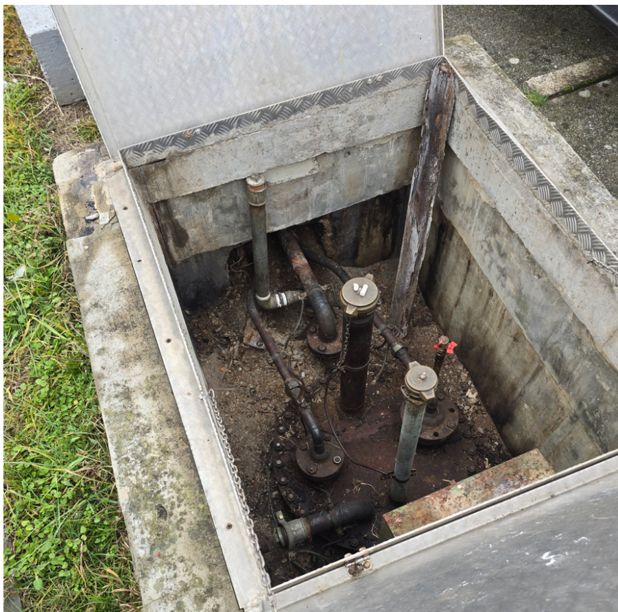
Slika 3: Stari podzemni rezervoar
