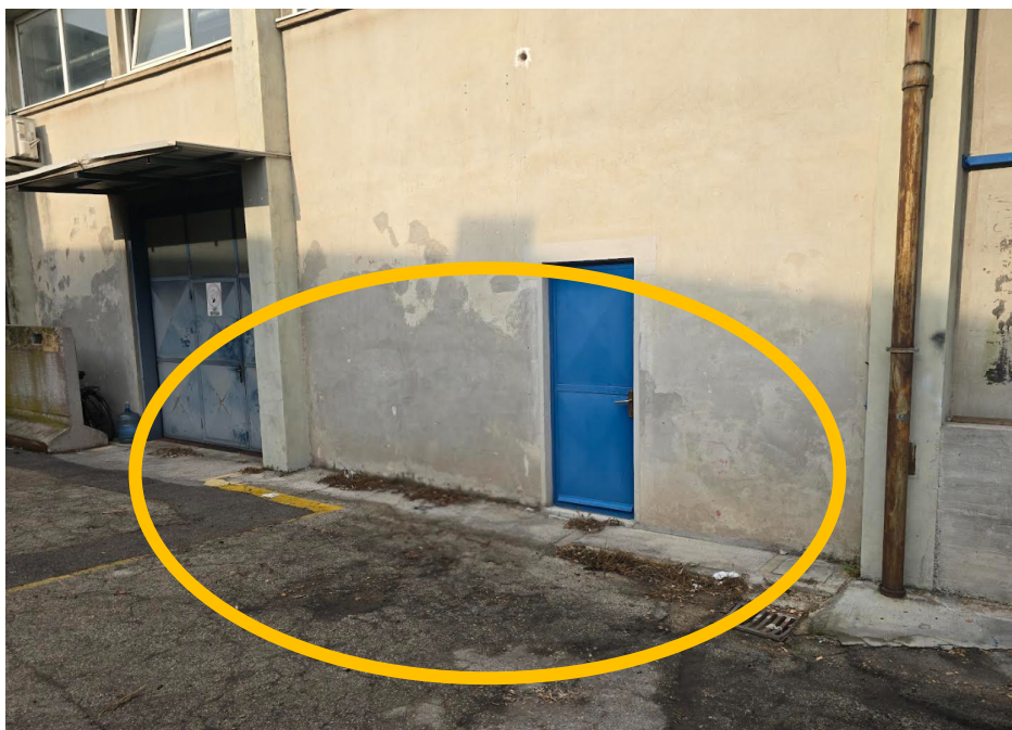
Slika 2: Predvidena lokacija novega nadzemnega rezervoarja (se dogovori pri izvedbi)
