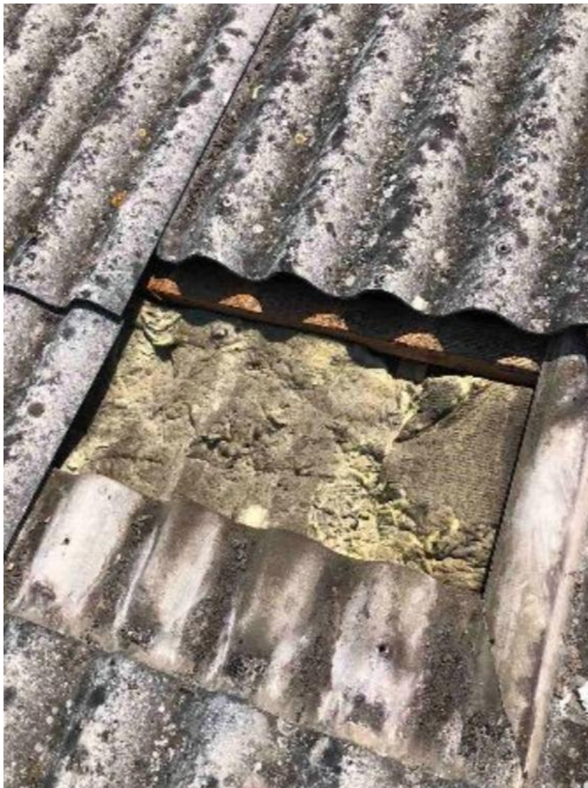
Slika 2: Prikaz obstoječe kritine in izolacije (kamena Volna).
