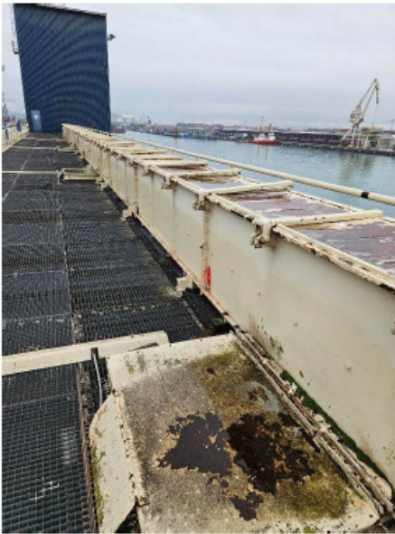
Slika 2. - 3. Prikaz stanja pokrovov pnevmatskih zapiračev in zgornje prekorodirane pločevine
