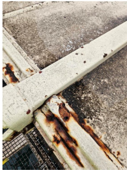
Slika 2. - 3. Prikaz stanja pokrovov pnevmatskih zapiračev in zgornje prekorodirane pločevine
