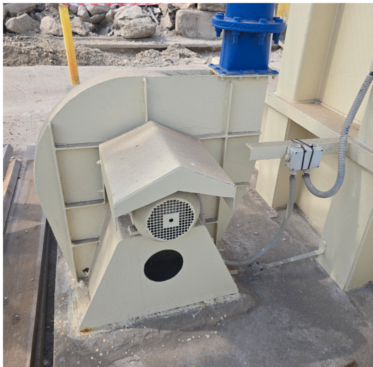
Slika 2: Stari, dotrajan ventilator
