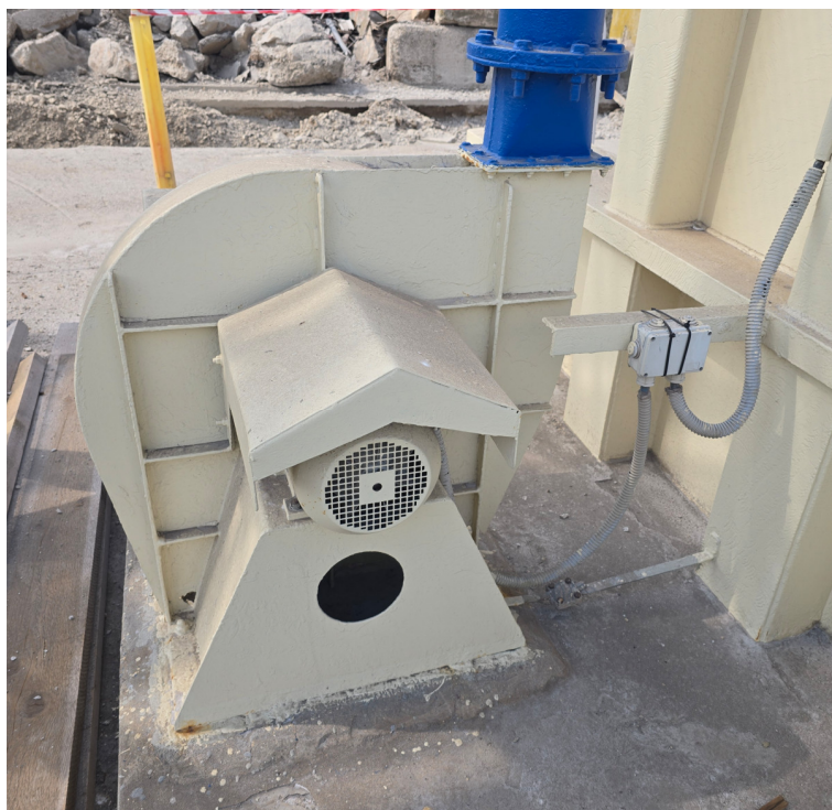
Slika 2: Stari, dotrajan ventilator
